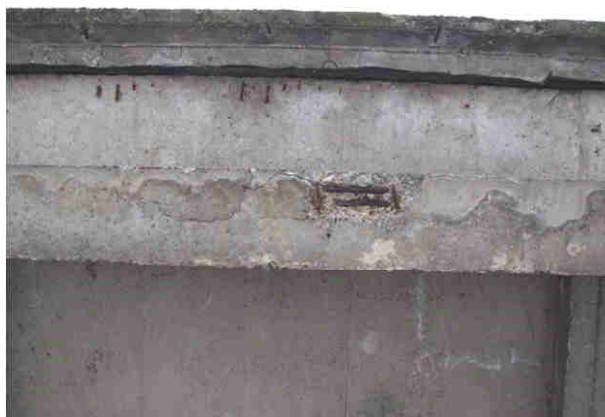
Fot. 3.13. Stan techniczny dźwigarów głównych – uszkodzenia w postaci lokalnych odspojień otuliny betonowej z widocznymi strzemionami i prętami głównymi wykazującym oznaki korozji powierzchniowej.
