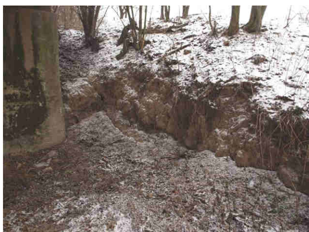
Fot. 3.30. Stan techniczny nasypu przy wjeździe od strony Niemodlina (po stronie północno-zachodniej) – widoczna wegetacja roślin na stożkach nasypowych, rozległe ubytki gruntu i erozja materiału, deformacje terenu oraz ogólne zanieczyszczenia
