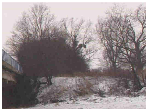
Fot. 3.29. Stan techniczny nasypu przy wjeździe od strony Lewina Brzeskiego (po stronie północno-wschodniej) – widoczna wegetacja roślin na stożkach nasypowych, ubytki i erozja materiału, deformacje terenu i ogólne zanieczyszczenia
