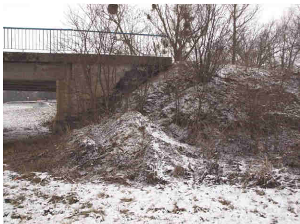
Fot. 3.29. Stan techniczny nasypu przy wjeździe od strony Lewina Brzeskiego (po stronie północno-wschodniej) – widoczna wegetacja roślin na stożkach nasypowych, ubytki i erozja materiału, deformacje terenu i ogólne zanieczyszczenia
