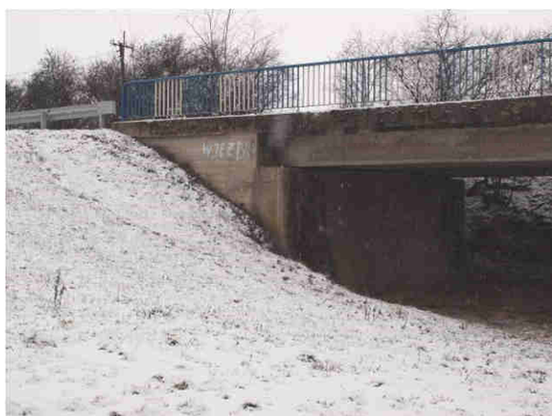
Fot. 3.31. Stan techniczny nasypu przy wjeździe od strony Niemodlina (po stronie południowo-wschodniej) – niewielka wegetacja roślin na stożkach nasypowych
