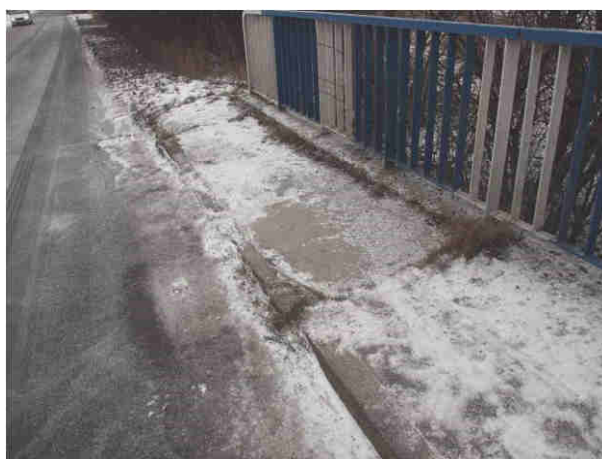
Fot. 3.5. Stan techniczny nawierzchni chodnika i krawężników na obiekcie (od WG) – uszkodzenia w postaci lokalnych ubytków betonu nawierzchni chodników na obiekcie, miejscowych zniszczeń struktury wierzchniej warstwy nawierzchni, osiadań betonowych płyt na dojeściach do obiektu
