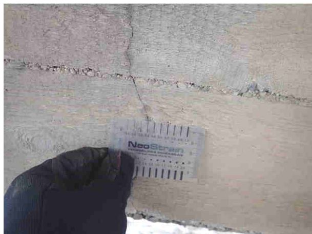
Zarysowanie prostopadłe do osi podłużnej oczepu, w środku jego rozpiętości
