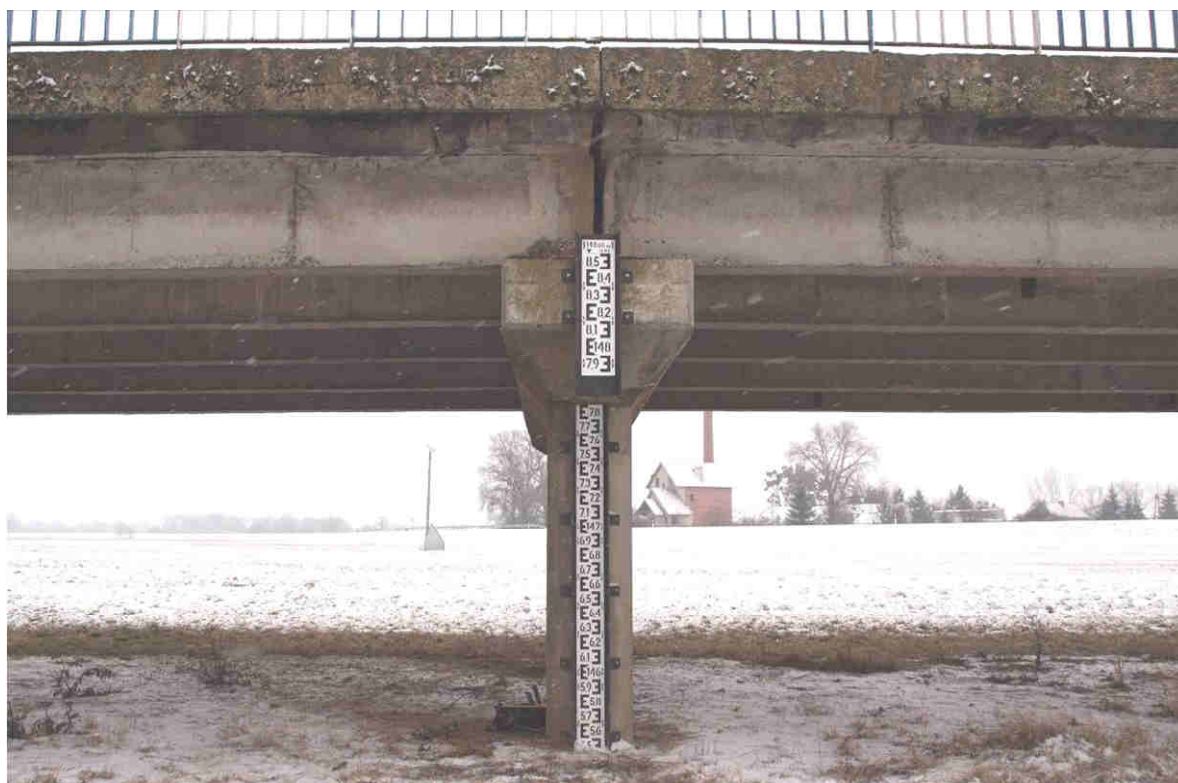
Fot. 2.22 Widok ogólny na łatę wodowskazową zlokalizowaną na obiekcie
