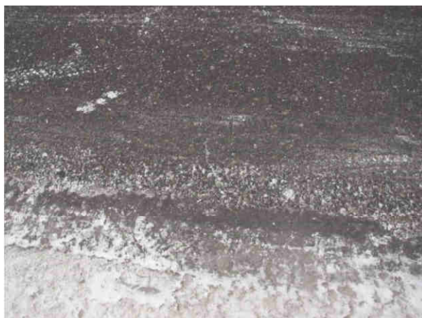
Fot. 3.2. Stan techniczny nawierzchni na dojeździe do obiektu od strony Niemodlina – uszkodzenia w postaci deformacji, zanieczyszczeń, zarysowań i pęknięć oraz ubytków materiału (głównie na krawędziach) asfaltowej nawierzchni jak również wegetacji roślinności na jej krawędziach
