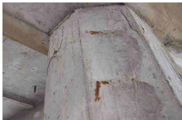
Fot. 3.23. Stan techniczny słupów – widoczne uszkodzenia w postaci pionowych zarysowań na słupach podpór
