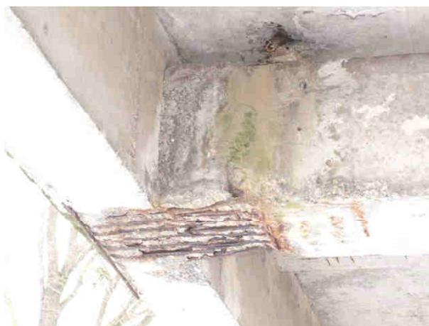
Fot. 4.4b Widok na obserwowane typy korozji zbrojenia (cd)
