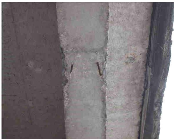
Fot. 3.13. Stan techniczny dźwigarów głównych – uszkodzenia w postaci lokalnych odspojień otuliny betonowej z widocznymi strzemionami i prętami głównymi wykazującym oznaki korozji powierzchniowej.
