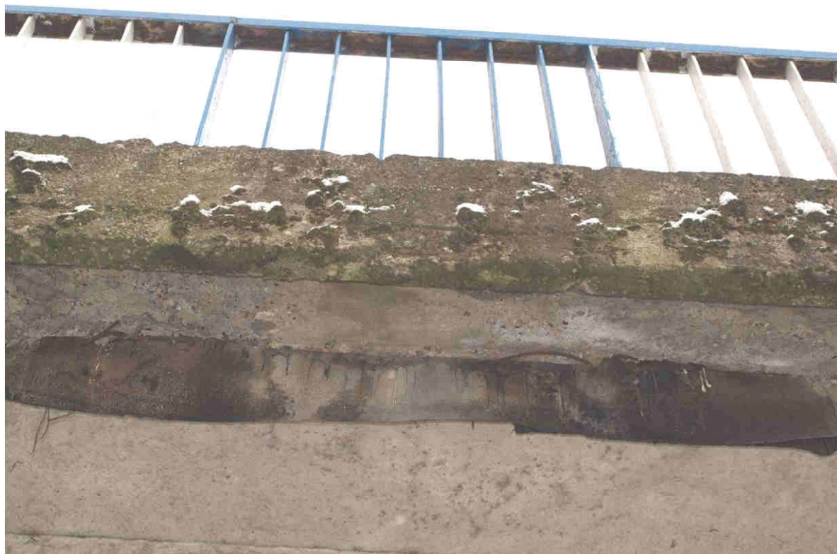
Fot. 2.11 Widok ogólny na izolację przeciwwodną płyty pomostowej z papy
