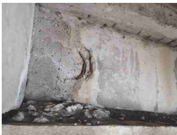
Fot. 3.19. Stan techniczny poprzecznic podporowych – uszkodzenia w postaci zarysowań i odspojień otuliny betonowej na połączeniu poprzecznic podporowych z dźwigarami, połączone z intensywną korozją wżerową zbrojenia.
