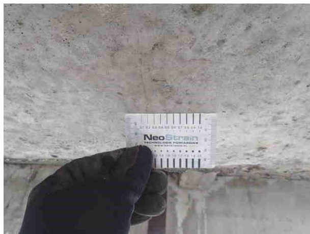
Zarysowanie prostopadłe do osi podłużnej dźwigara głównego, w środku rozpiętości
