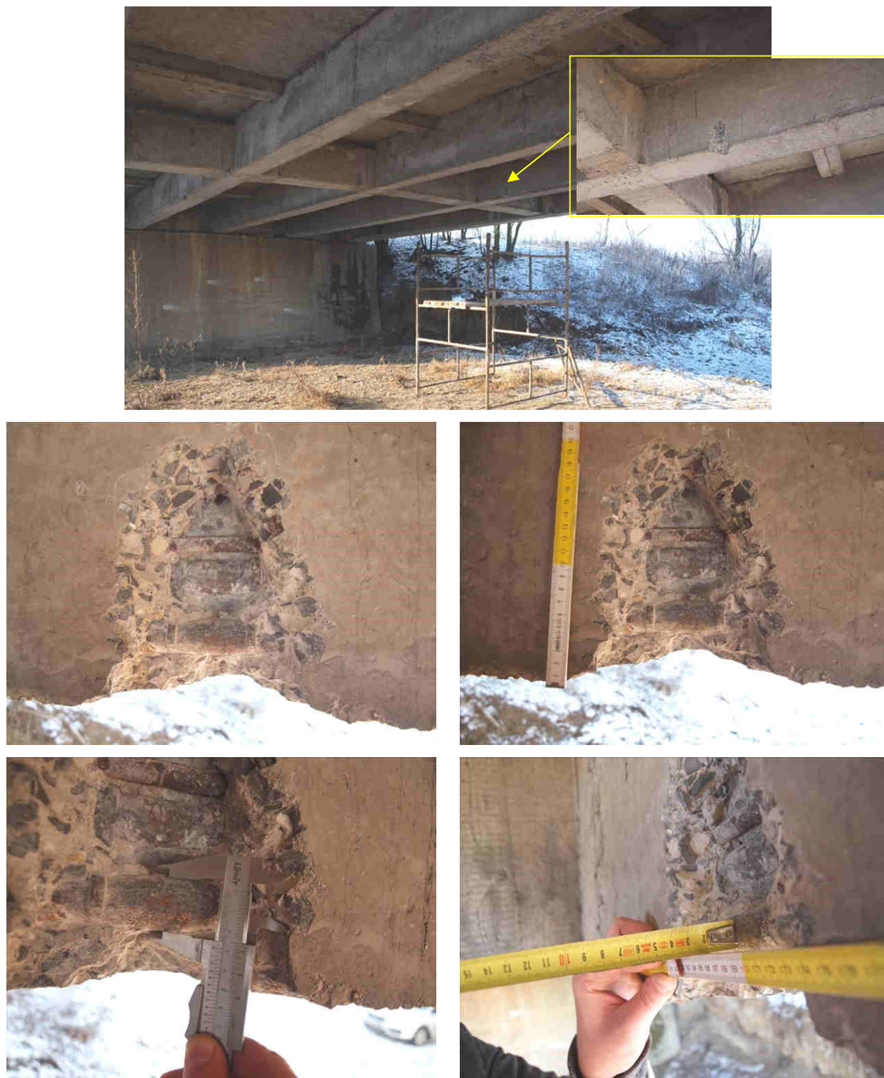
Fot. 4.1 Widok na prace związane z inwentaryzacją zbrojenia
