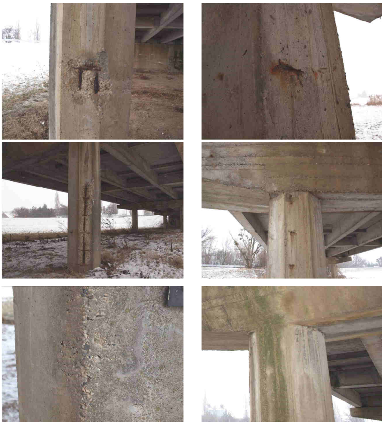
Fot. 3.24. Stan techniczny słupów – widoczne uszkodzenia w postaci lokalnych ubytków betonowej otuliny słupów z odsłonięciem korodujących prętów zbrojeniowych, przebarwień, wyrakowań i zacieków organicznych na słupach podpór
