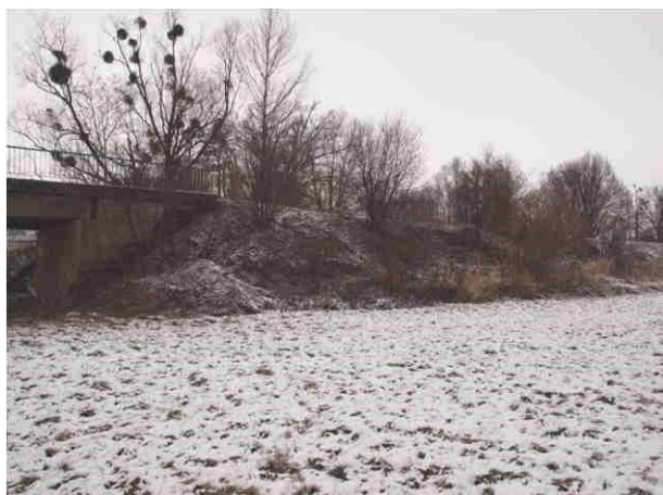
Fot. 3.29. Stan techniczny nasypu przy wjeździe od strony Lewina Brzeskiego (po stronie północno-wschodniej) – widoczna wegetacja roślin na stożkach nasypowych, ubytki i erozja materiału, deformacje terenu i ogólne zanieczyszczenia
