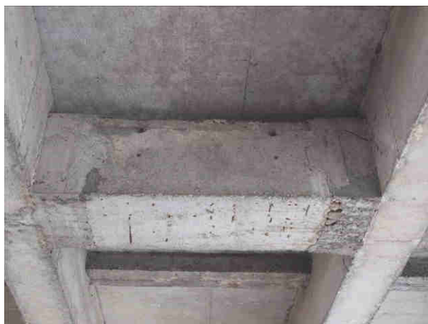
Fot. 3.16. Stan techniczny poprzecznic przęsłowych – uszkodzenia w postaci zarysowania otuliny betonowej na połączeniu poprzecznic przęsłowych z dźwigarami wewnętrznymi z widocznymi objawami korozji zbrojenia
