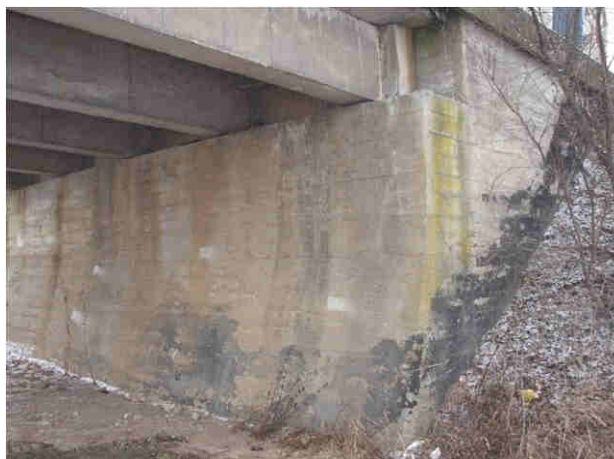
Fot. 3.22. Stan techniczny przyczółka od strony Lewina Brzeskiego – widoczne uszkodzenia w postaci wyrakowień oraz lokalnych deformacji i ubytków betonu, przebarwień oraz zanieczyszczeń organicznych i nieorganicznych betonu, wegetacji roślinności
