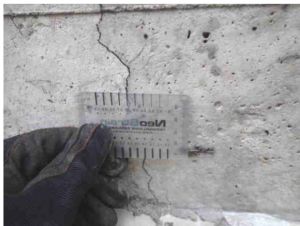
Zarysowanie wspornika prostopadłe do osi podłużnej
