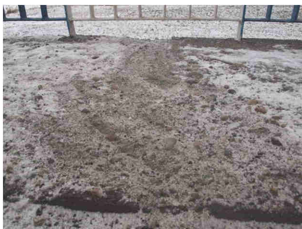
Fot. 3.5. Stan techniczny nawierzchni chodnika i krawężników na obiekcie (od WG) – uszkodzenia w postaci lokalnych ubytków betonu nawierzchni chodników na obiekcie, miejscowych zniszczeń struktury wierzchniej warstwy nawierzchni, osiadań betonowych płyt na dojeściach do obiektu
