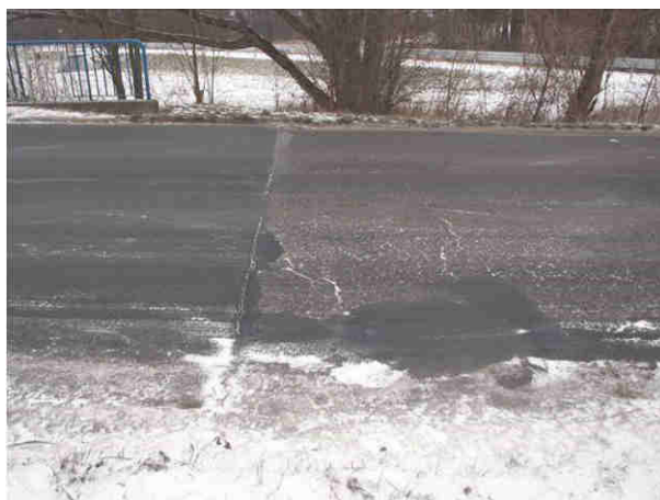
Fot. 3.1. Stan techniczny nawierzchni na dojeździe do obiektu od strony Lewina Brzeskiego – uszkodzenia w postaci deformacji, zanieczyszczeń, zarysowań i pęknięć oraz ubytków materiału (głównie na krawędziach ) asfaltowej nawierzchni
