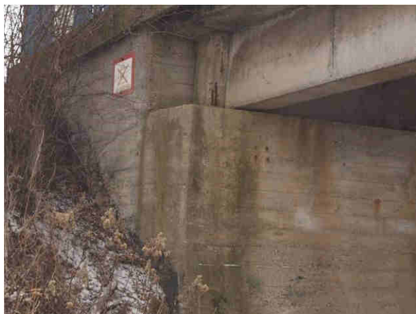
Fot. 3.22. Stan techniczny przyczółka od strony Lewina Brzeskiego – widoczne uszkodzenia w postaci wyrakowień oraz lokalnych deformacji i ubytków betonu, przebarwień oraz zanieczyszczeń organicznych i nieorganicznych betonu, wegetacji roślinności
