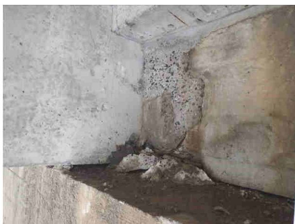
Fot. 3.19. Stan techniczny poprzecznic podporowych – uszkodzenia w postaci zarysowań i odspojień otuliny betonowej na połączeniu poprzecznic podporowych z dźwigarami, połączone z intensywną korozją wżerową zbrojenia.
