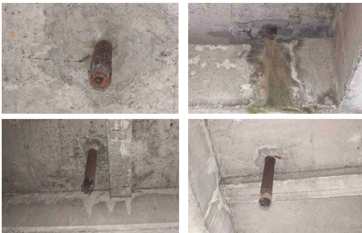
Fot. 3.4. Stan techniczny urządzeń odwadniających – uszkodzenia w postaci zaawansowanej korozji powierzchniowej i wżerowej połączone z rozległymi ubytkami materiału rur spustowych, całkowitego braku powłok malarskich antykorozyjnych, niewłaściwego usytuowania rur spustowych
