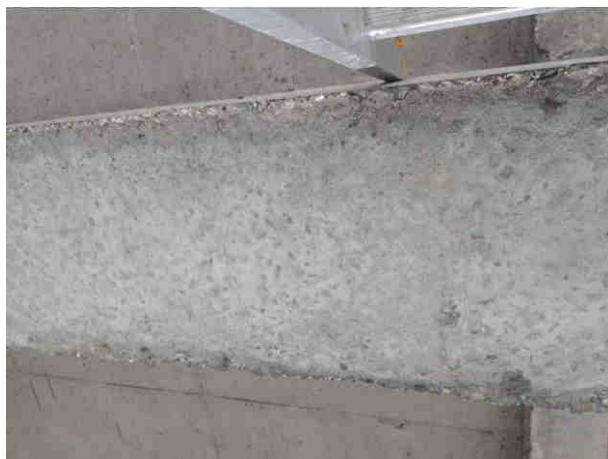
Zarysowanie prostopadłe do osi podłużnej dźwigara głównego, w środku rozpiętości
