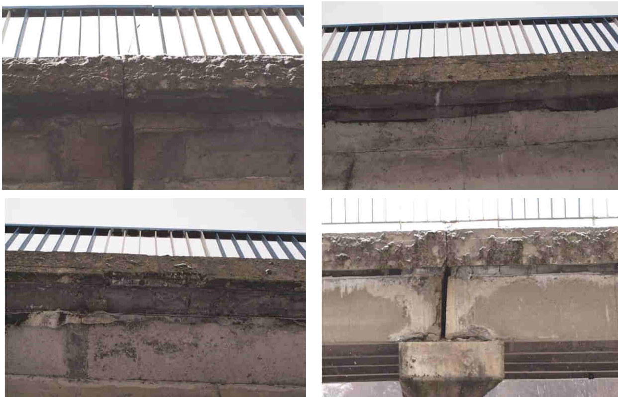
Fot. 3.8. Stan techniczny gzymsów – uszkodzenia w postaci zanieczyszczenia i ubytków betonu z korozją stali zbrojeniowej gzymsów, blokada swobody przemieszczeń gzymsów w strefach przerw dylatacyjnych, wegetacji roślin
