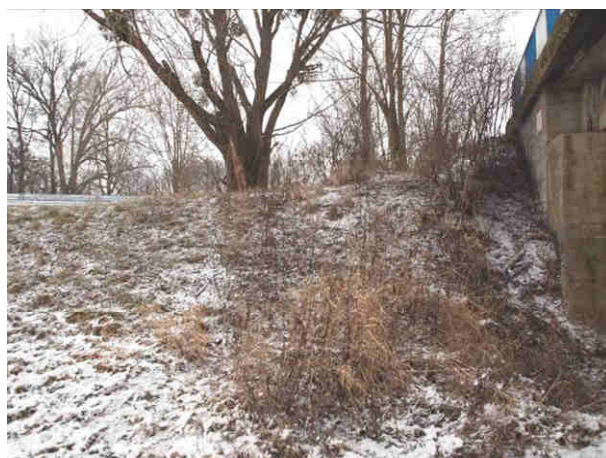
Fot. 3.28. Stan techniczny nasypu przy wjeździe od strony Lewina Brzeskiego (po stronie północno-zachodniej) – widoczna wegetacja roślin na stożkach nasypowych, ubytki i erozja materiału, deformacje terenu i ogólne zanieczyszczenia
