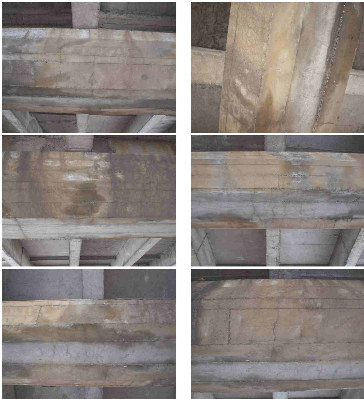
Fot. 3.27. Stan techniczny oczepów – widoczne uszkodzenia w postaci poprzecznych zarysowań w środku ich rozpiętości
