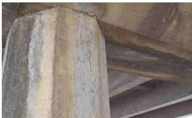
Fot. 3.23. Stan techniczny słupów – widoczne uszkodzenia w postaci pionowych zarysowań na słupach podpór
