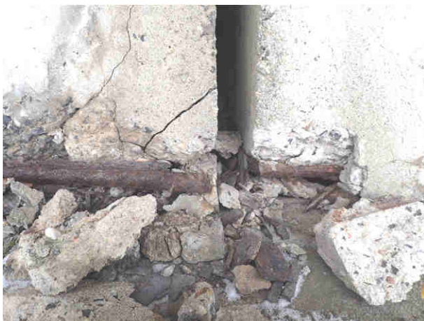
Fot. 4.4a Widok na obserwowane typy korozji zbrojenia (cd)
