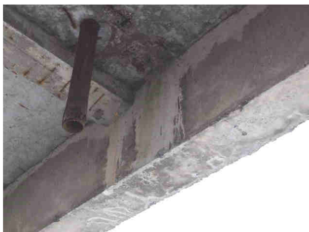
Fot. 3.11. Stan techniczny płyty pomostowej – uszkodzenia w postaci lokalnych ubytków otuliny zbrojenia z odsłoniętym zbrojeniem wykazującym oznaki korozji powierzchniowej i wżerowej na żebrach płyty pomostowej
