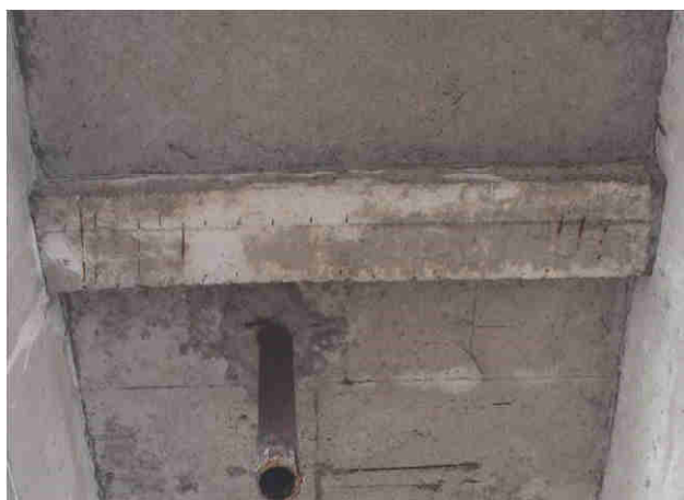
Fot. 3.11. Stan techniczny płyty pomostowej – uszkodzenia w postaci lokalnych ubytków otuliny zbrojenia z odsłoniętym zbrojeniem wykazującym oznaki korozji powierzchniowej i wżerowej na żebrach płyty pomostowej
