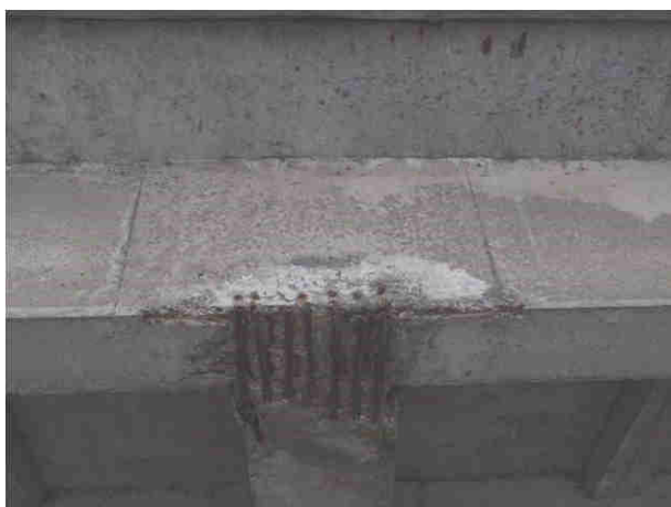
Fot. 3.15. Stan techniczny poprzecznic przęsłowych – uszkodzenia w postaci odspojień otuliny betonowej na połączeniach poprzecznic przęsłowych z dźwigarami skrajnymi połączonych z intensywną korozją wżerową zbrojenia
