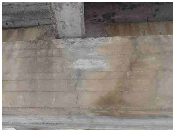
Zarysowanie prostopadłe do osi podłużnej oczepu, w środku jego rozpiętości
