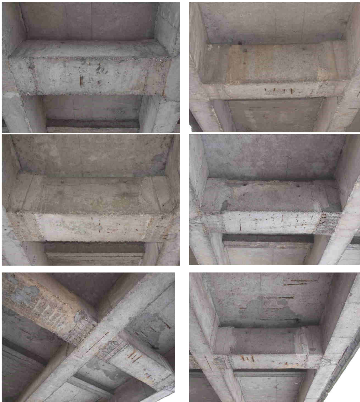
Fot. 3.17. Stan techniczny poprzecznic przęsłowych – uszkodzenia w postaci wyrakowień, lokalnego zarysowania i odspojień otuliny betonowej z odsłonięciem korodujących prętów zbrojeniowych poprzecznic przęsłowych w strefach pomiędzy dźwigarami
