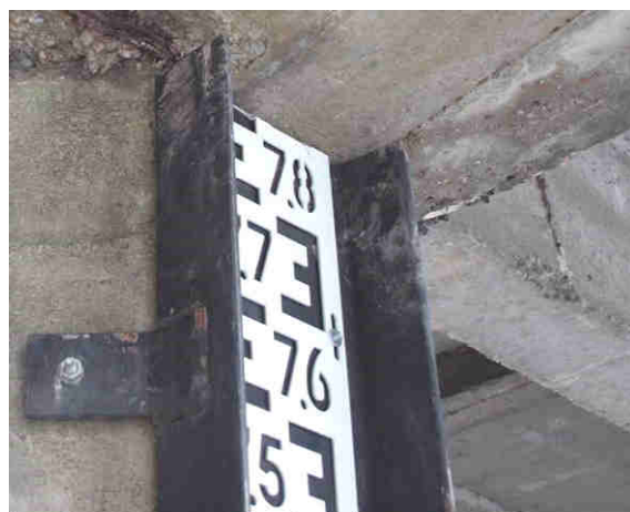
Fot. 3.33. Stan techniczny łaty wodowskazowej – widoczne punktowe miejsca korozji powierzchniowej
