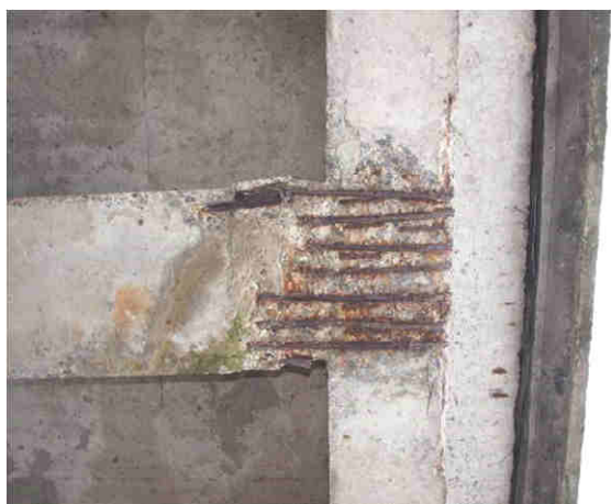
Fot. 3.15. Stan techniczny poprzecznic przęsłowych – uszkodzenia w postaci odspojień otuliny betonowej na połączeniach poprzecznic przęsłowych z dźwigarami skrajnymi połączonych z intensywną korozją wżerową zbrojenia
