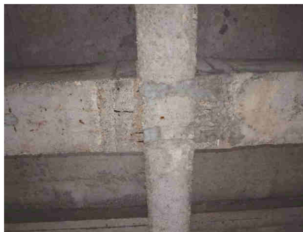
Fot. 3.16. Stan techniczny poprzecznic przęsłowych – uszkodzenia w postaci zarysowania otuliny betonowej na połączeniu poprzecznic przęsłowych z dźwigarami wewnętrznymi z widocznymi objawami korozji zbrojenia
