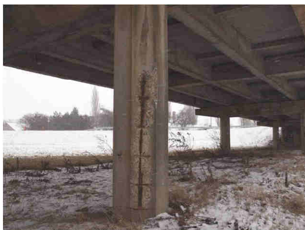
Fot. 4.4b Widok na obserwowane typy korozji zbrojenia (cd)
