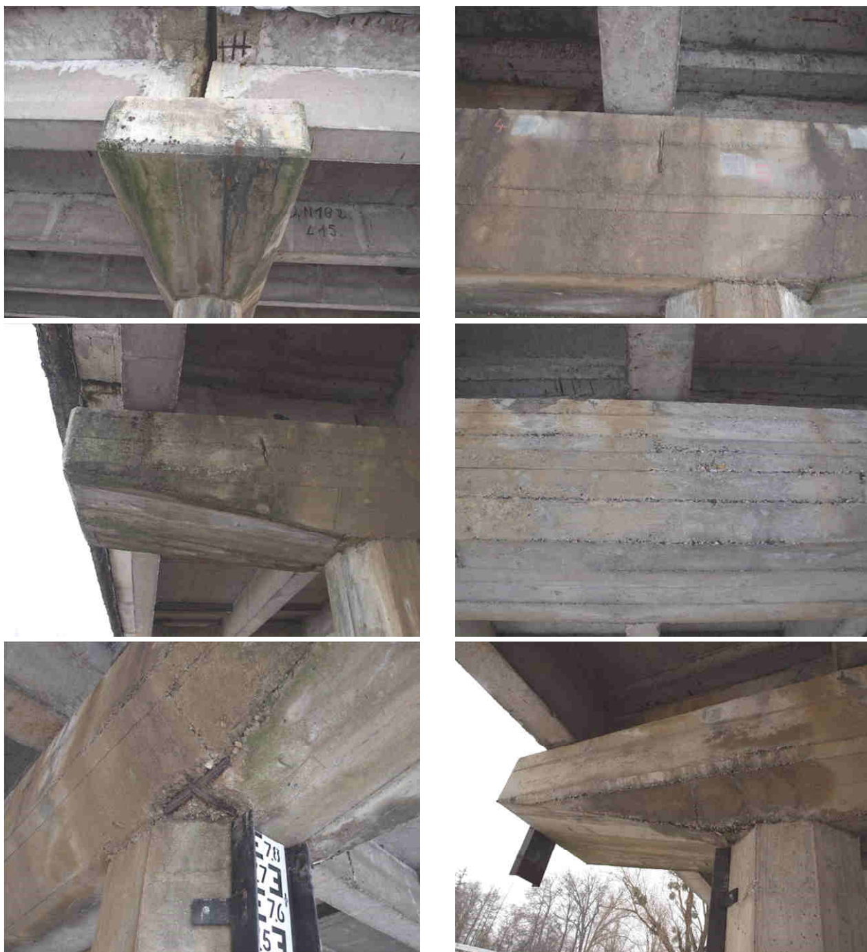
Fot. 3.26. Stan techniczny oczepów – widoczne uszkodzenia w postaci rdzawych i organicznych zacieków, wyrakowień i ubytków materiału, zawilgocenia betonu, lokalnych odspojień otuliny z odstonięciem korodujących prętów zbrojeniowych oczepów
