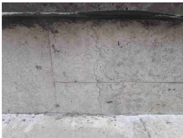
Zarysowanie wspornika prostopadłe do osi podłużnej
