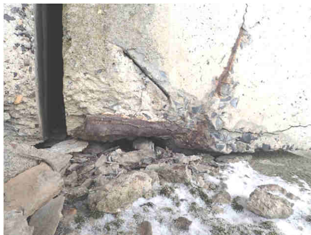
Fot. 4.4a Widok na obserwowane typy korozji zbrojenia (cd)
