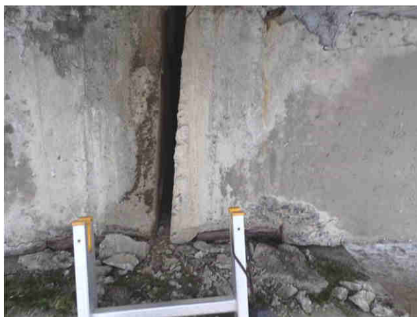
Fot. 3.14. Stan techniczny dźwigarów głównych – uszkodzenia w postaci zarysowania, pęknięcia i odspojenia betonu dźwigarów w strefach ich oparcia na podporach (strefach nadłożyskowych)
