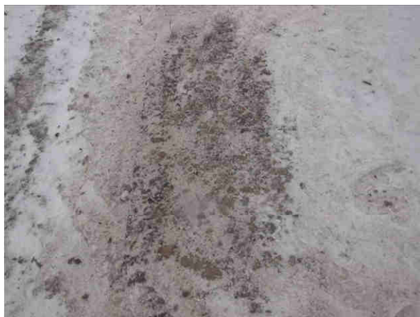
Fot. 3.6. Stan techniczny nawierzchni chodnika i krawężników na obiekcie (od WD) – uszkodzenia w postaci lokalnych ubytków betonu nawierzchni chodników na obiekcie, miejscowych zniszczeń struktury wierzchniej warstwy nawierzchni, osiadań betonowych płyt na dojazdach do obiektu
