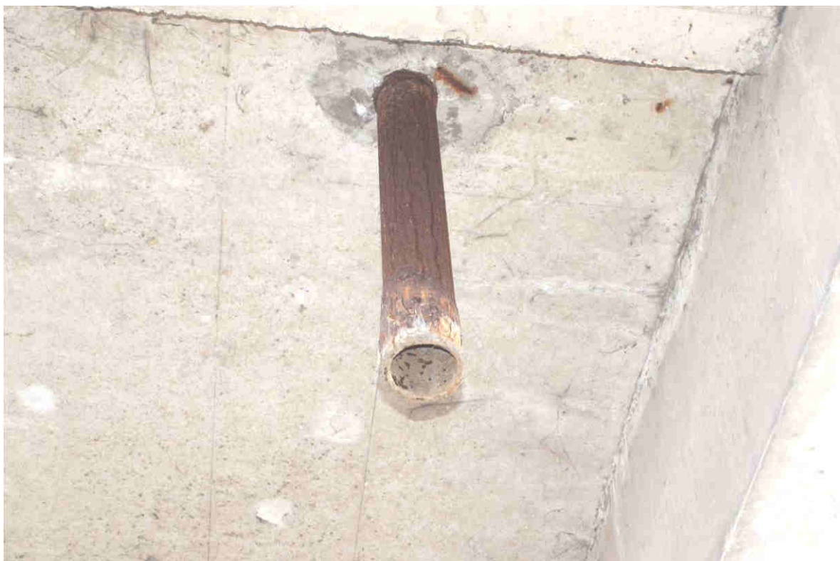
Fot. 2.7 Widok ogólny na sposób odprowadzenia wody poza obiekt – wylot z wpustu
