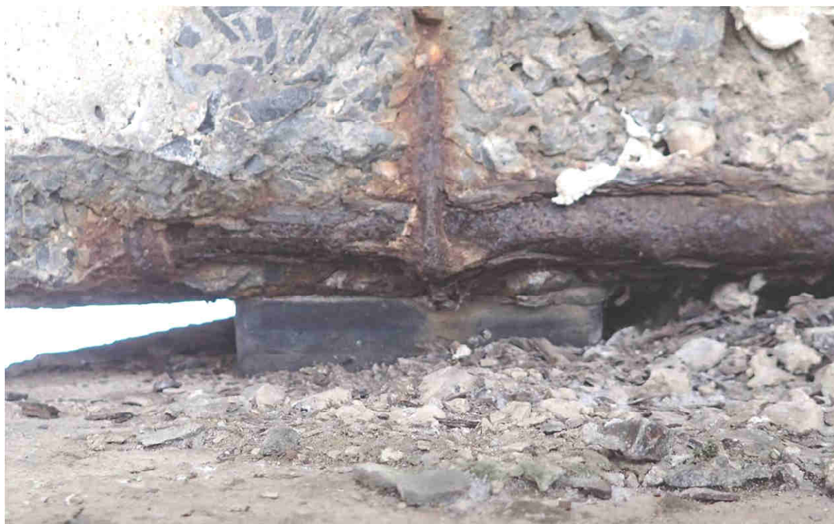
Fot. 2.18 Widok na oparcie dźwigarów głównych na podporach skrajnych oraz pośrednich za pośrednictwem gumowych przekładek
