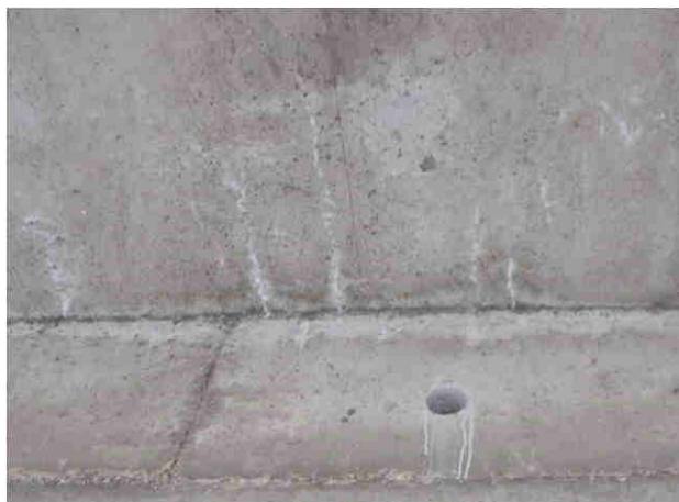
Fot. 3.12. Stan techniczny płyty pomostowej – uszkodzenia w postaci nieorganicznych i organicznych wykwitów oraz przebarwień widocznych od spodu płyty pomostowej
