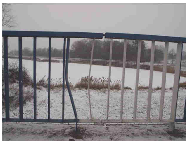
Fot. 3.7. Stan techniczny balustrad na obiekcie – uszkodzenia w postaci lokalnych uszkodzeń powłok antykorozyjnych, lokalnych ogniska korozji powierzchniowej, lokalnych deformacji i wygięcia materiału balustrad; ograniczenia możliwości przemieszczeń liniowych balustrad w strefach szczelin dylatacyjnych
