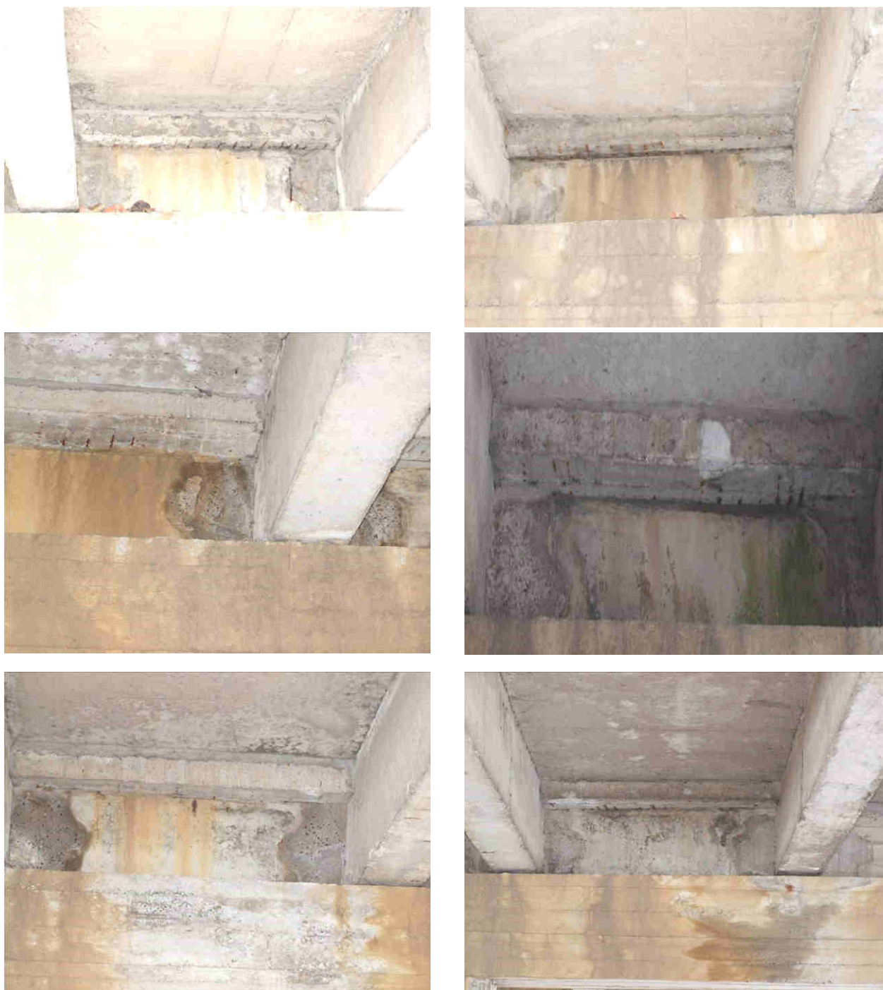
Fot. 3.18. Stan techniczny poprzecznic podporowych – uszkodzenia w postaci zarysowań otuliny betonowej, przebarwień i organicznych nacieków na powierzchni poprzecznic podporowych
