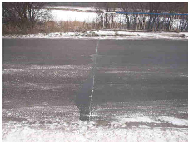
Fot. 3.2. Stan techniczny nawierzchni na dojeździe do obiektu od strony Niemodlina – uszkodzenia w postaci deformacji, zanieczyszczeń, zarysowań i pęknięć oraz ubytków materiału (głównie na krawędziach) asfaltowej nawierzchni jak również wegetacji roślinności na jej krawędziach
