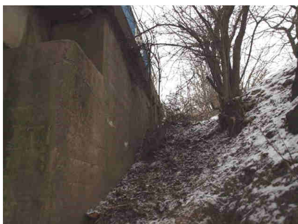
Fot. 3.30. Stan techniczny nasypu przy wjeździe od strony Niemodlina (po stronie północno-zachodniej) – widoczna wegetacja roślin na stożkach nasypowych, rozległe ubytki gruntu i erozja materiału, deformacje terenu oraz ogólne zanieczyszczenia
