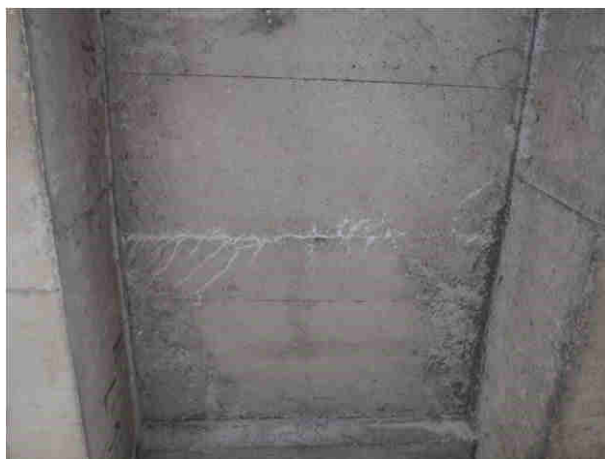
Fot. 3.9. Stan techniczny płyty pomostowej – uszkodzenia w postaci lokalnych zarysowań płyty pomostowej.
