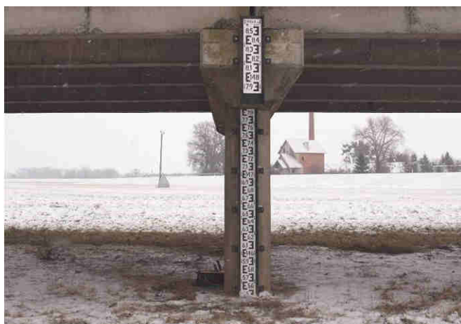
Fot. 3.33. Stan techniczny łaty wodowskazowej – widoczne punktowe miejsca korozji powierzchniowej
