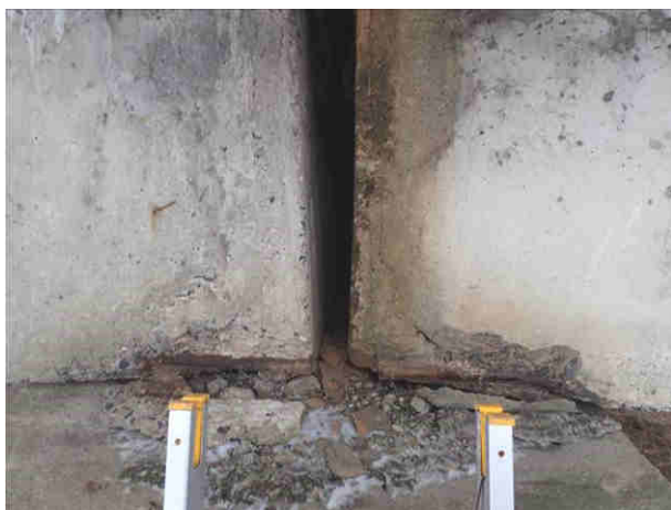
Fot. 3.14. Stan techniczny dźwigarów głównych – uszkodzenia w postaci zarysowania, pęknięcia i odspojenia betonu dźwigarów w strefach ich oparcia na podporach (strefach nadłożyskowych)
