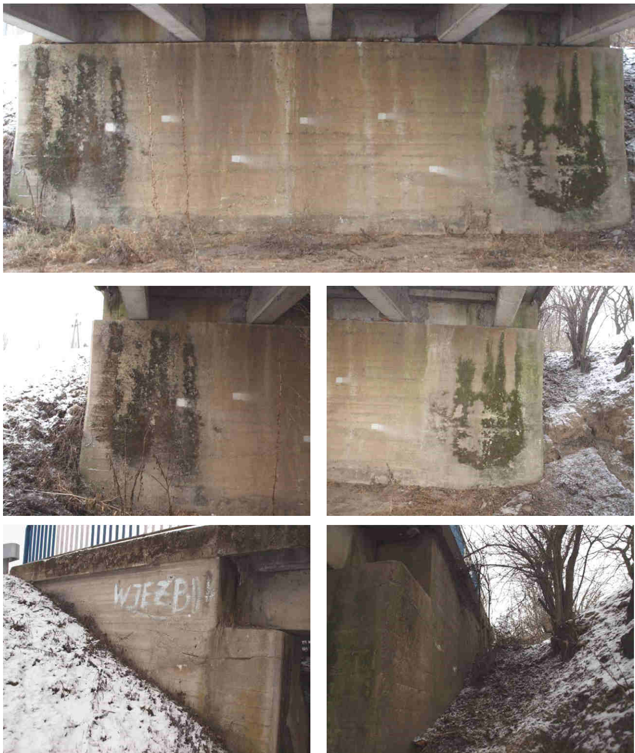
Fot. 3.21. Stan techniczny przyczółka od strony Oldrzychowic – widoczne uszkodzenia w postaci wyrakowań oraz lokalnych deformacji i ubytków betonu, miejscowo odsłoniętych prętów zbrojeniowych z oznakami korozji powierzchniowej, przebarwień oraz zanieczyszczeń organicznych i nieorganicznych betonu, wegetacji roślinności
