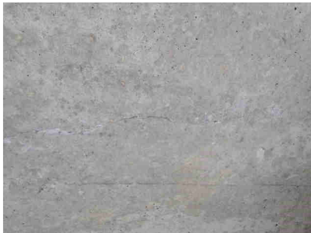
Zarysowanie płyty pomostowej, prostopadłe do osi podłużnej, pomiędzy dźwigarami
